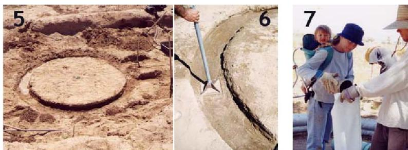
4) Die Tür gegen Wind und Wasser. 5) Graben Sie das Fundament 30 cm tief. 6) Begradigen und Stampfen. (Das Fundament besteht aus 2-3 ausgefüllten Sack Reihen.) 7) Legen Sie den Beutel in den Graben, das Ende falten zum schließen, starten der Füllung wie eine kurze aufrechte Säule.
