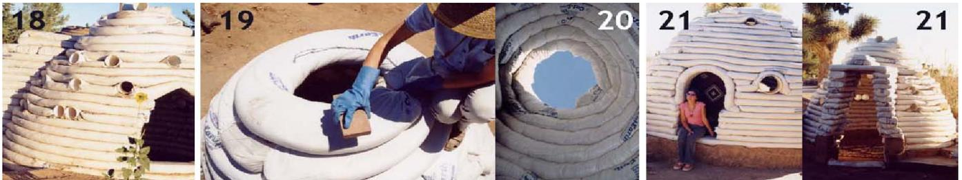
19) Beim Stampfen der obere Zeilen, nicht auf dem nassen Beutel Stehen. 20) Platziere die Säcke der oberen Zeilen von außen, nach innen zum Kompass Kreis, auffüllen und Stampfen der Sacke sanftem Hang zu nach außen. 21) Fügen Sie einen gewölbten Eingang ein (Tür-Bogen), nach außen gestreckt, um die Öffnung zu schützen.
