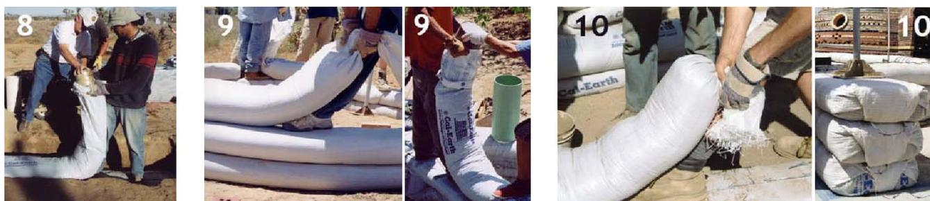
8) Immer 2-3 Dosen Erde füllen und schütteln bis zum Ende. 9) Mit der Schwerkraft als Hilfe, Sack auf dem Bein langsam rückwärts gehen, beim füllen - nicht belasten. Füllen Sie die Säcke möglichst gut, und überprüfen Sie die Position mit dem Kompass-Werkzeug. 10) Sack zum schließen drehen und unter die Enden verstauen.
