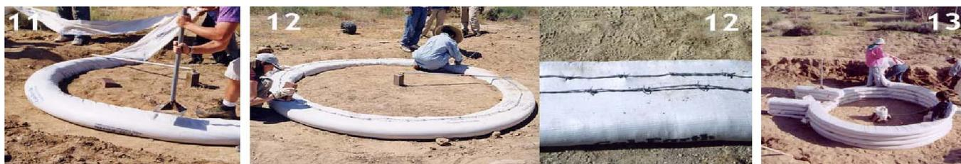
11) Kompakt hart gefüllte Säcke, verwenden eines Stampfer, um einen glatten, festen einheitlichen Block machen zu können. Nur Stampf-Erde wird stark. 12) Kontinuierlich Stacheldraht auflegen - 1 Draht für Kuppeln bis zu 4m, 2 Drähte für größere. Wo Pausen auftreten, überlappen sich die Drähte um (65 cm). 13) Weiterhin Sackreihen aufsetzen.
