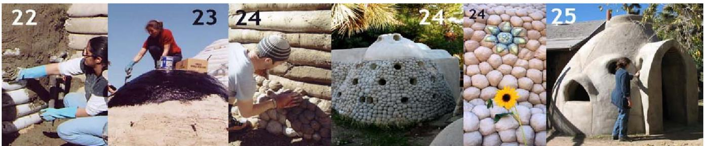
22) Außen Putz anbringen bevor Säcke zerfallen und 23) gegen Wasser abdichten mit lokal geeigneten Materialien (Teer), um Feuchtigkeit und Erosion zu widerstehen. 24) Darüber mit einem wasserfesten Zement/Kalk/Kugel putzen 25) ein glatter Zement oder Kalk Putz.
