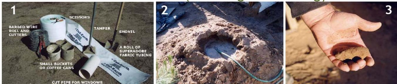
1) Besorgen Sie die oben genannten Teile. 2) Vorbereitung der Erde-Mischung, die mit Zement oder Kalk oder Asphalt-Emulsion stabilisiert ist. 3) Wasser zufügen, in der Hand zu einem Ball gedrückt, darf kein Wasser raus laufen. 4) Wenn keine Zement / Kalk verfügbar ist, verwenden Sie Roh Erde nur für einen vorübergehenden Schutz. (Experiment - fülle Schnee in Sack und Presse.)
